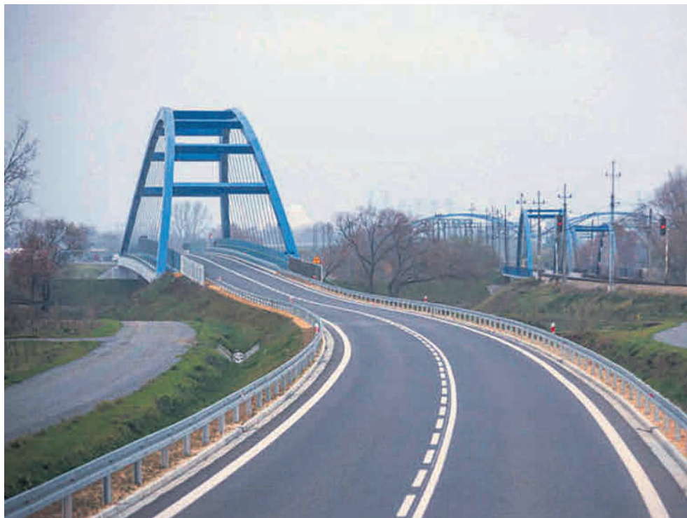
Prace na obwodnicy Czarnowasów będą prowadzone w nocy.
